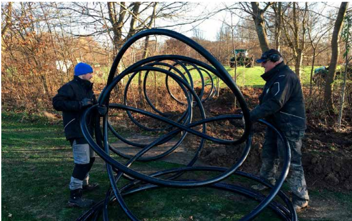
Greenkeeperne i gang med at udlægge vandingsanlæg på par 3-banen
